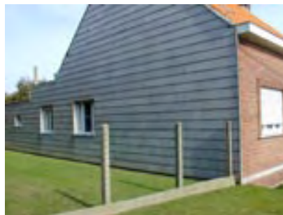
Revêtement de façade en amiante-ciment
