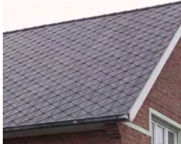
Ardoises en amiante-ciment
