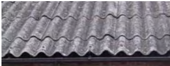
Exemple d'application non friable : plaques ondulées
